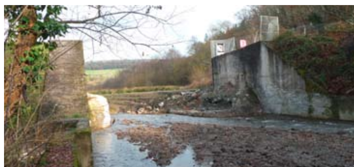
L'ouvrage avant et après la première phase des travaux de cet été.
